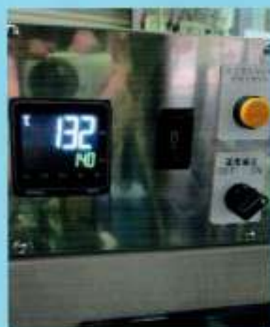
温度上下限検出器取り付け
