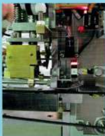
レーザーセンサーの取り付け
